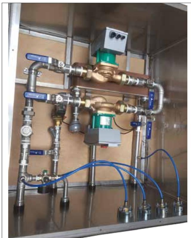
Устройство разделения системы между блоками и чиллером.
